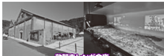
敦賀赤レンガ倉庫
