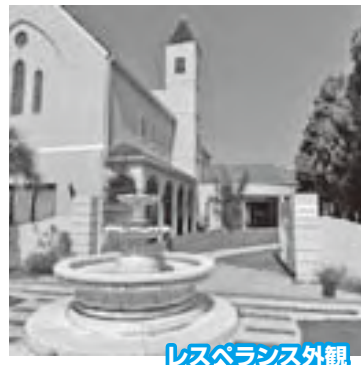
レスペランス外観
