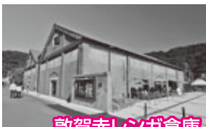
敦賀赤レンガ倉庫
